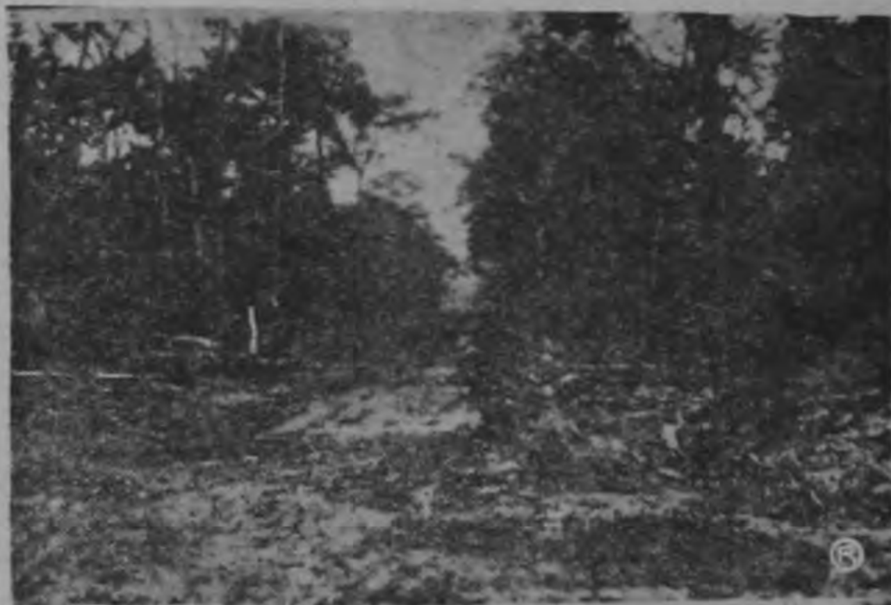
Iniciación de los trabajos de la Carretera Patiño - Calmita (12½ Kmts.) obra del Ministerio de Obras Públicas. Licitación adjudicada a la "Cia. Conama". Esta carretera entroncará Calmita y Home Creek con Puerto Viejo y el Rio Sixaola.
